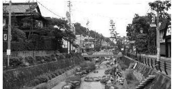
温泉街・護岸工事されたあとの玉湯川の様子
